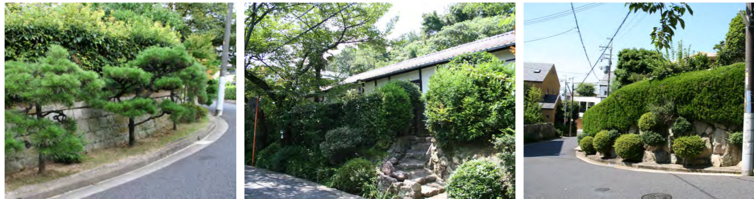
(左) 雲雀丘山手地区でも特に古い、開発初期の犬走り。(中央) 開発初期は「道路断面は掘削した土砂などを利用して埋め立て、石垣を施工して植栽するなど、砂防対策を行う。」と定めていた。(右) 犬走りが残る邸宅。道路と宅盤に高低差があるため、立ち上がり石垣にし、さらに緑化している。
