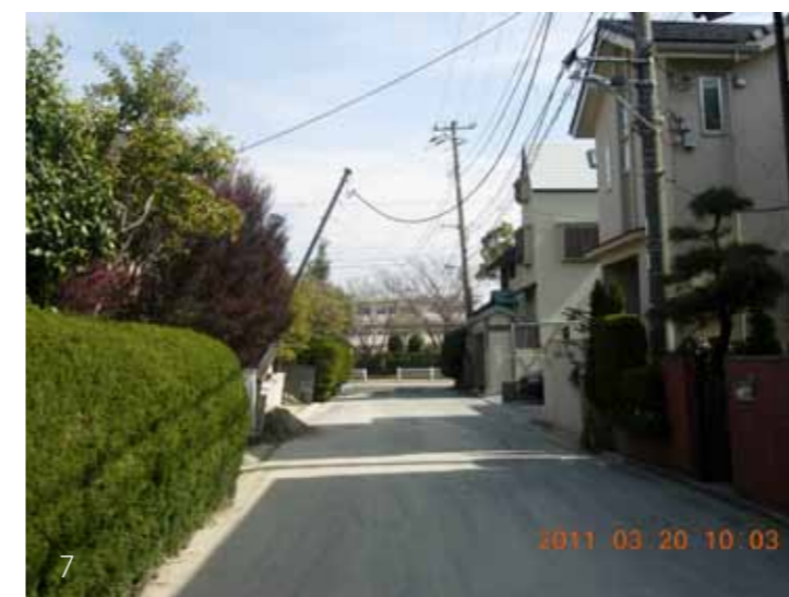
1. 震災3日後の庭の様子。本震後の余震で片付けた汚泥が再び湧き出し、何度も片づけを繰り返すことに。2. 汚泥の深さは十数cm。3. 各戸の庭から流れ出した汚泥はまちの道路に溜まり、重機による片づけも行われた。4.K邸前の通りの様子。片付けた泥はビニールに入れて、各戸の前に積まれていった。5. 大きく傾いた富岡交番。液状化による地盤沈下被害を顕著に物語る事例である。震災から数ヶ月後には取り壊された。6. 液状化によって大きく傾いた電柱。7.Kさんが住む美浜地区でも電柱が大きく傾いた場所もあった。(P3-4の写真は全てKさん撮影)
