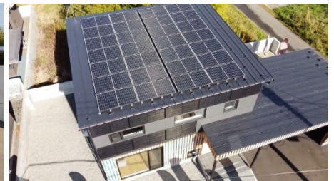
屋根面の太陽光パネル
