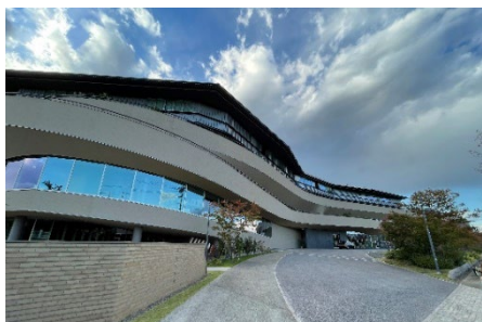
自然素材を用い曲線で構成された外観
