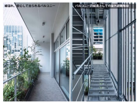
窓の外に設けられたベランダと避難階段
