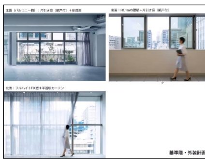
建物両面の開閉可能な窓による採光と通風
