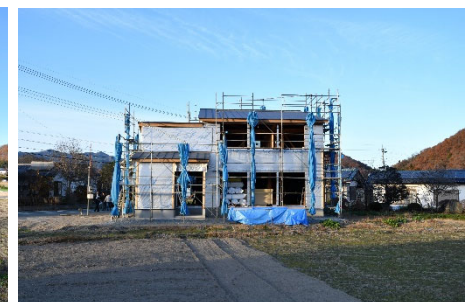
秩父パッシブハウス 2024（工事中）／外観
