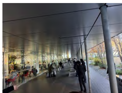
高層棟 ピロティ
