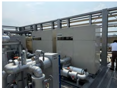
屋上設備スペース
