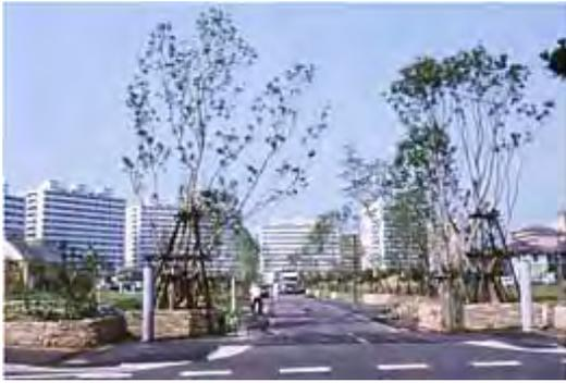
先行植栽を実施。地下水位が高いため根腐れしないよう宅地は道路面より約1m高くしている。
