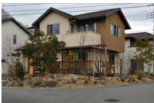
外構の土留めには地域で産出される自然石を利用。
