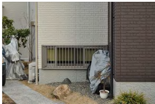
通風に役立つ地窓。ルーバーによる防犯対策も考慮されている。
