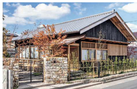
【図1-12】地域の伝統的な材料（焼杉）を用いた外観の例 （国府市場の家）
