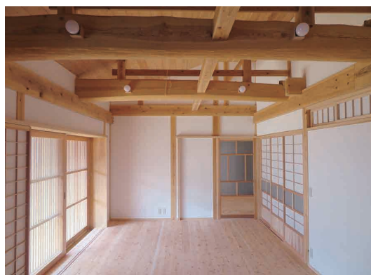
大きな窓、引戸、欄間によって通風を確保した室内空間
