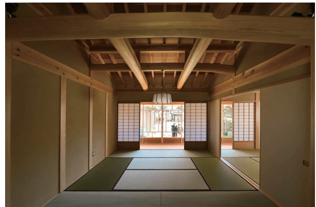
太鼓梁と土壁で構成された重厚感のある内観
