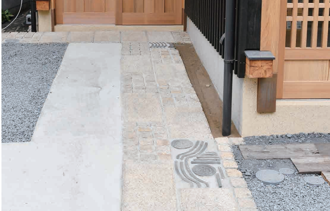
地表面の温度上昇抑制に配慮した透水性の外構
