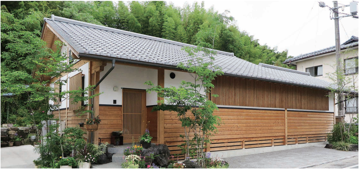
格子の垂直ラインと板壁の水平ラインで構成された外観
