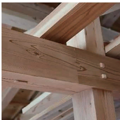
手刻みによる加工、 伝統的な継手仕
