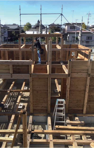
仮設住宅から再生転用する構造材
