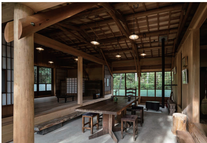
いかだ丸太を現（あらわ）にした開放的な土間空間
