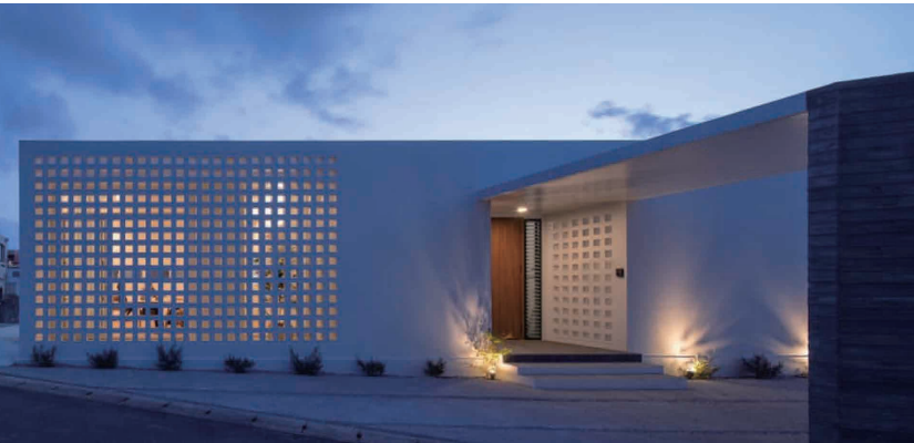
花ブロックから漏れる柔らかい光
