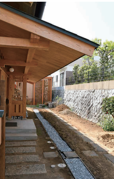
雨水を浸透させる雨落ち
