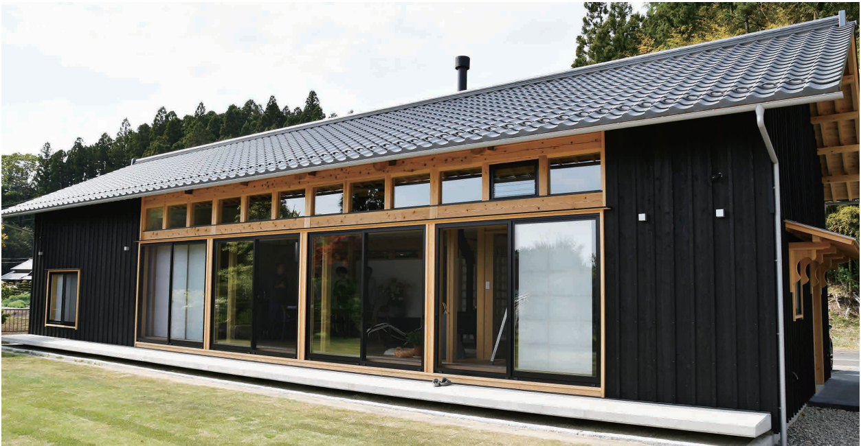
地域の集落に調和し地形に配慮した現代的な外観
