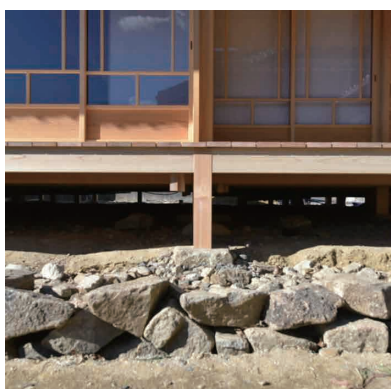
開放的な床下（石場建て）
