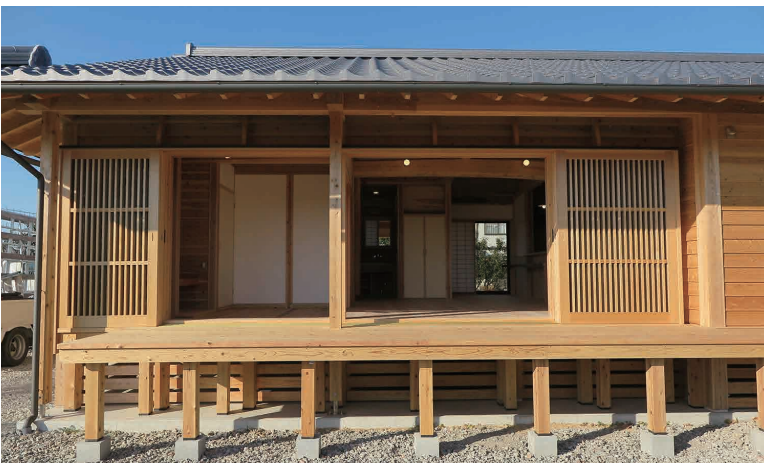
通風と日射遮蔽の両立を図った面格子のある大開口
