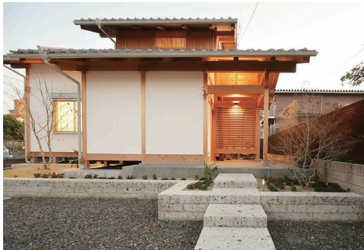
準防火地域内の伝統的な土塗壁による真壁・石場建ての外観
