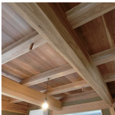
断面が大きな構造材の使用
