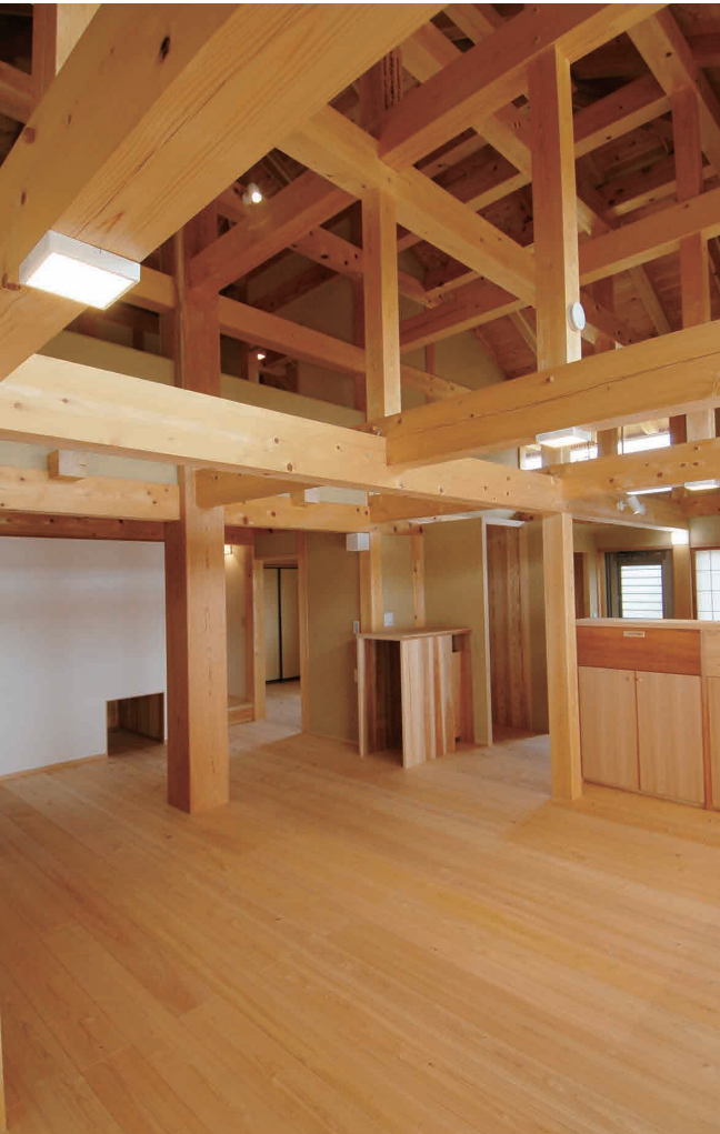
力強い多重梁の木組みが交差する吹抜けと高天井
