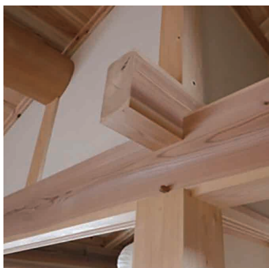
手刻みによる加工、伝統的な継手仕口 ▲
