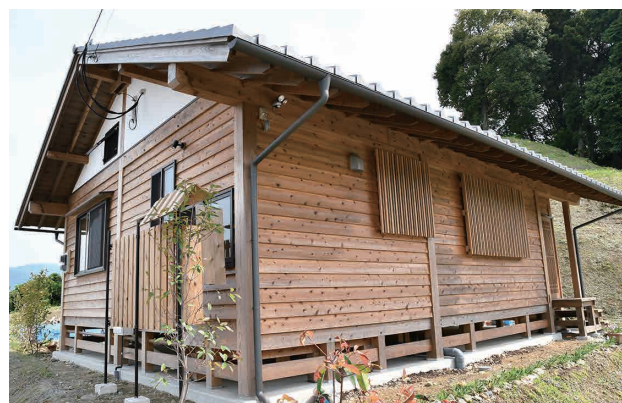
雨から土塗壁を保護する板張り
