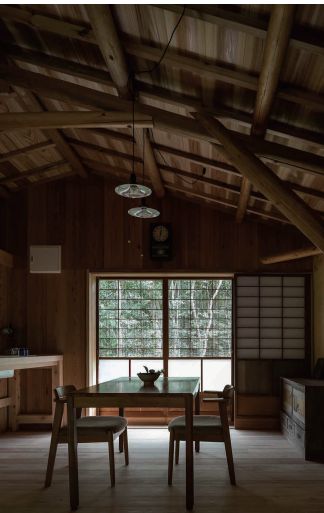
西洋の屋根構法（シザートラス）と日本の伝統的な木組みの技術を重ねた内観
