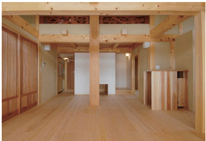
無垢の製材や床板、土塗壁、紙障子などを多用した室内
