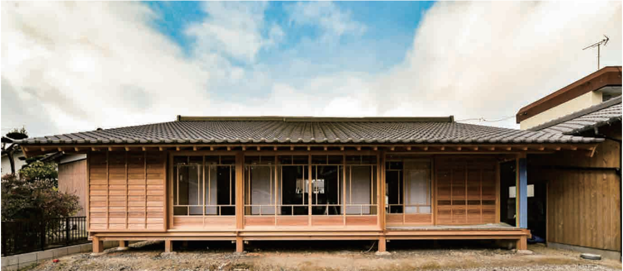
深い軒下空間に連続する大きな窓と縁側
