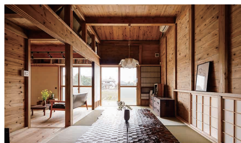
杉の厚板を用いた落とし込み板壁で構成された室内
