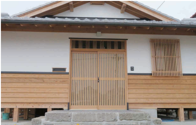
風雨から外壁を守る深い軒と板壁
