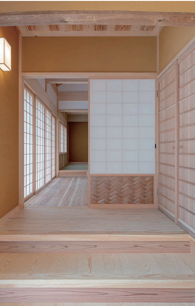
土塗壁と無垢材により高い調湿性能のある内部空間
