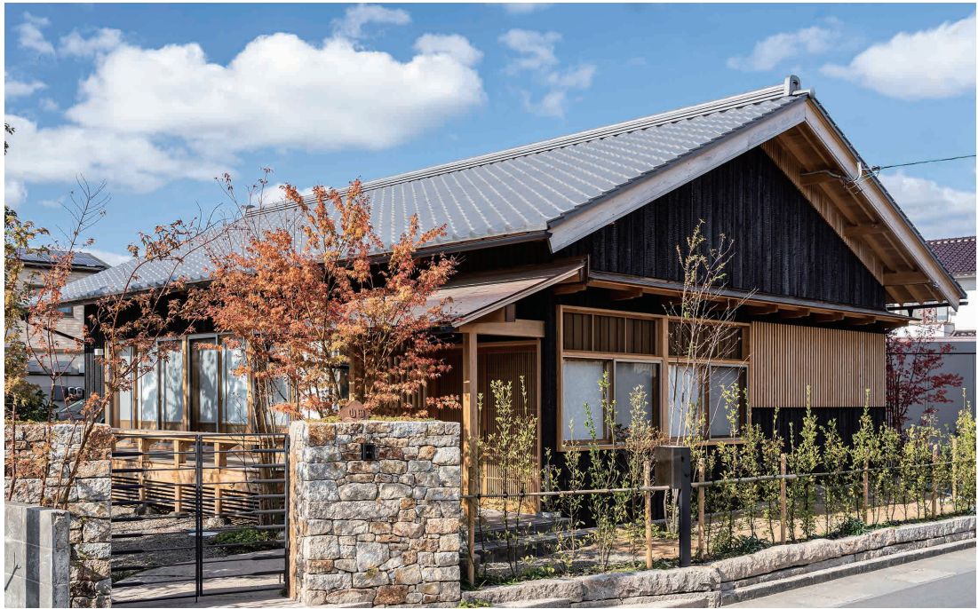
地域の景観に溶け込むよう外壁に焼杉を用いた外観
