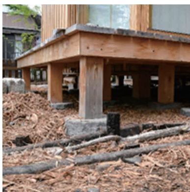
開放的な床下 (石場建て) ▲ ▲
