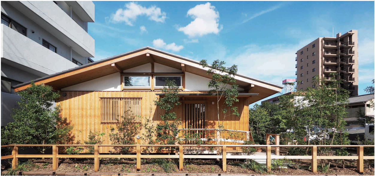
市街地景観の中で伝統的な軸組と板壁を採用した外観
