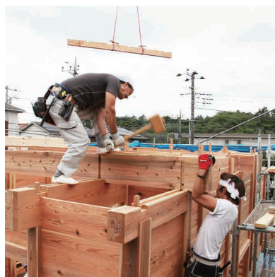
板壁 (落とし込み板壁)
