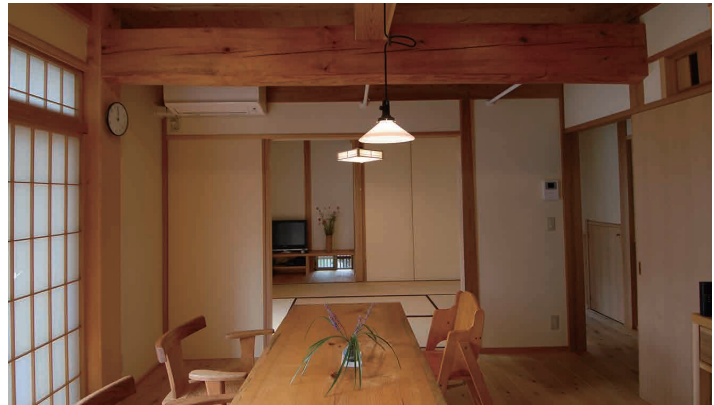
断面が大きく力強い構造体が現(あらわ)しになった食堂
