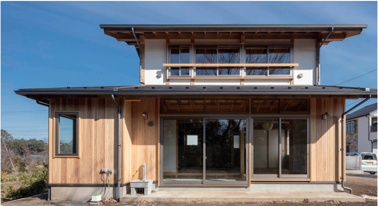
外壁上部を真壁漆喰塗り、腰部を杉板張りとして伝統的な竹まいを継承した外観
