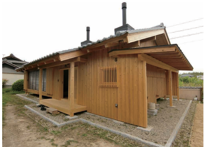
近隣に残るいぶし瓦屋根、杉目板張り外壁など地域になじむ外観
