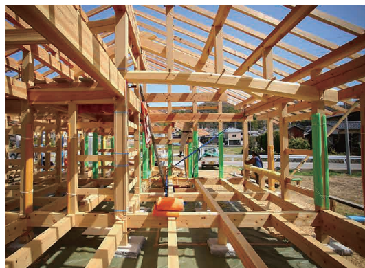
骨太の地域産材を活用した伝統構法の木組み、石場建て
