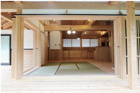
多層構成の木製建具を全開放できる大きな窓
