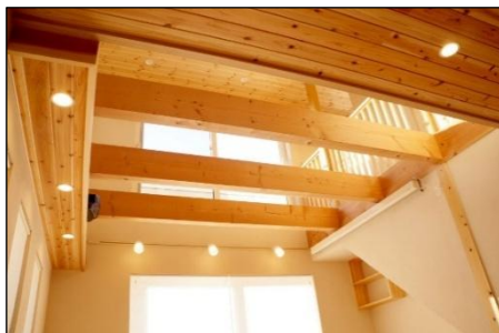
吹き抜けのある開放的な空間 出典：（一社）環境共生まちづくり協会撮影
