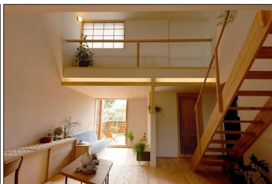
吹き抜け上部に設けられた天窓の例
