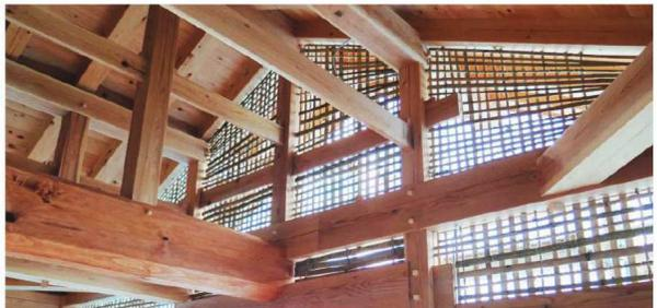
土塗壁漆喰塗り内外裏壁仕上げを支える竹小舞下地
