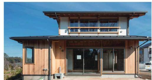
外壁上部を真鍮板葺き、腰部分を杉板葺きとして伝統的な佇まいを継承した外観
