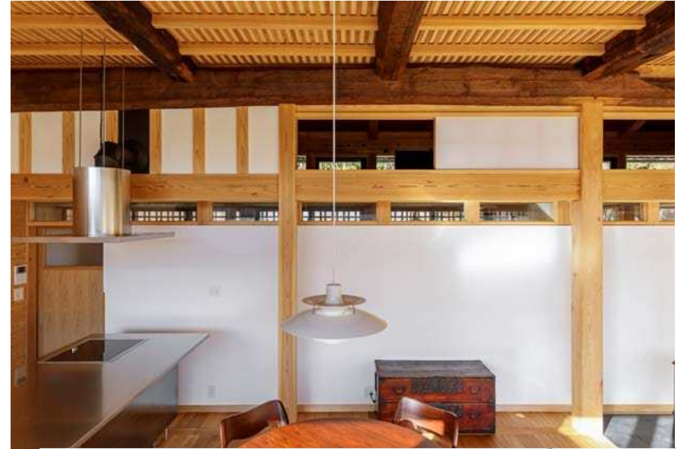
食堂。梁と桁の一部古材のマツ丸太を用い、天井は花ごぎの下に木木舞を編み、60mm角の竿で抑えている。壁は漆喰塗り。
